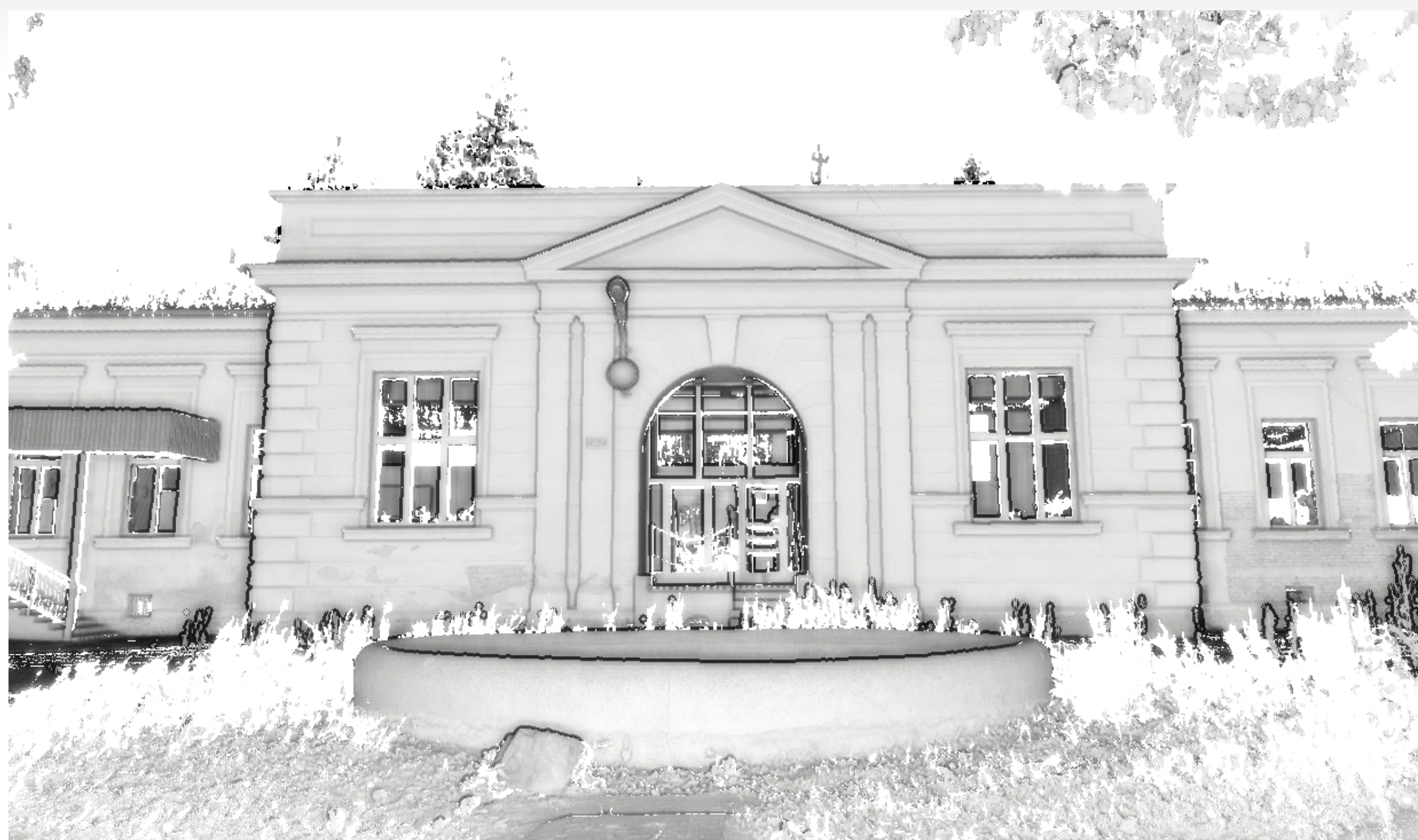
Mračno bodov z terestrického laserového skenovania - Hlavná budova
